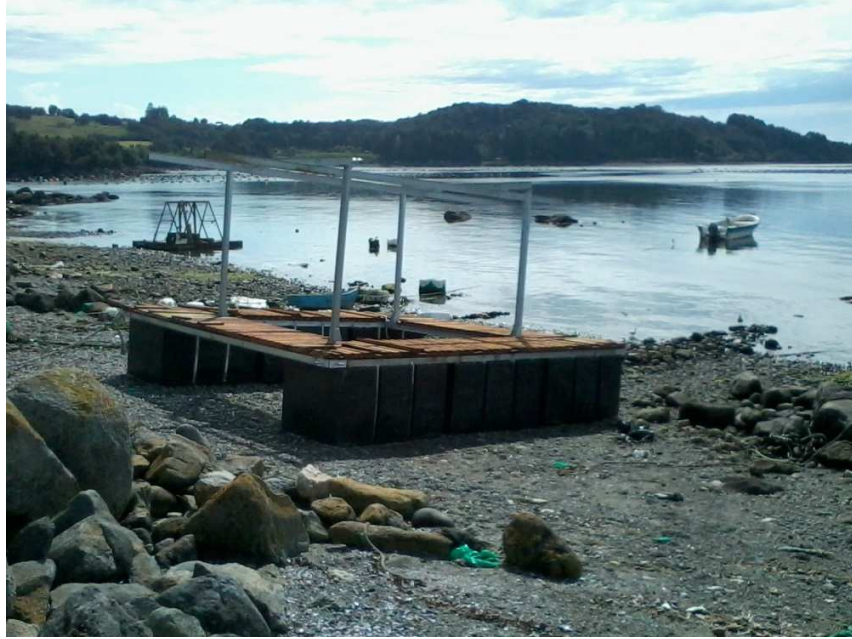
Foto 3.- Balsa terminada en sector Bahía Ilque, comuna de Calbuco.
