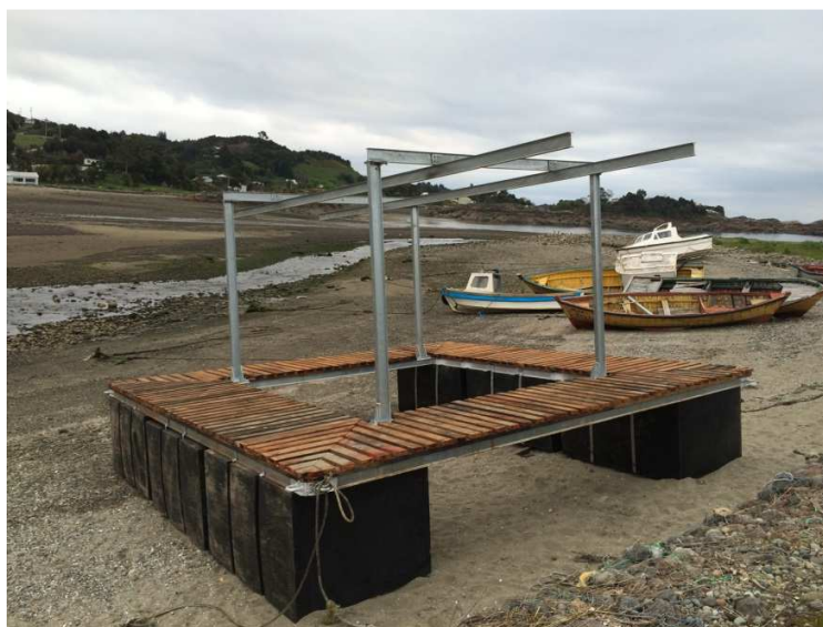
Foto 2.- Balsa terminada en sector Metri, carretera austral, comuna de Puerto Montt.
